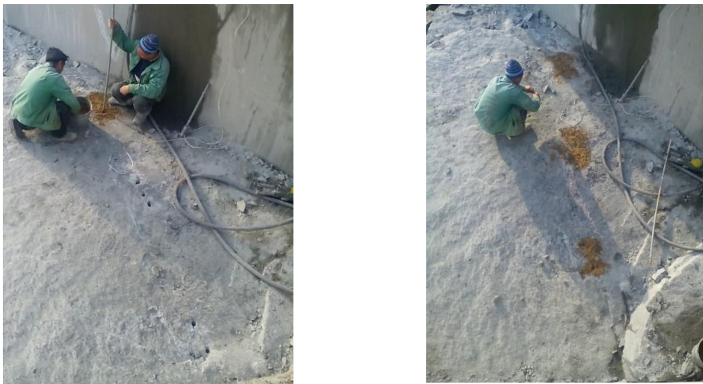
Рис. 6. Підготовка до проведення буровибухових робіт на блочному кар'єрі
